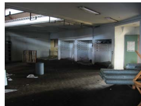
Bild 158-159. Byggnation av båsen i restaurangen
