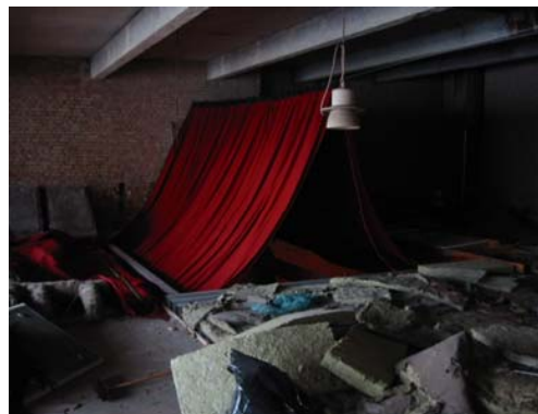
Bild 170. Isolering av taket i restaurangen.
