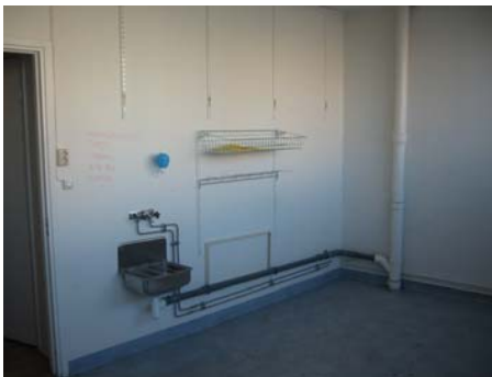
Bild 206. Städrummet hade vask och avlopp.
