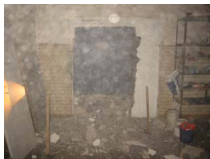
Bild 101-102. Rivning av tegelvägg.
