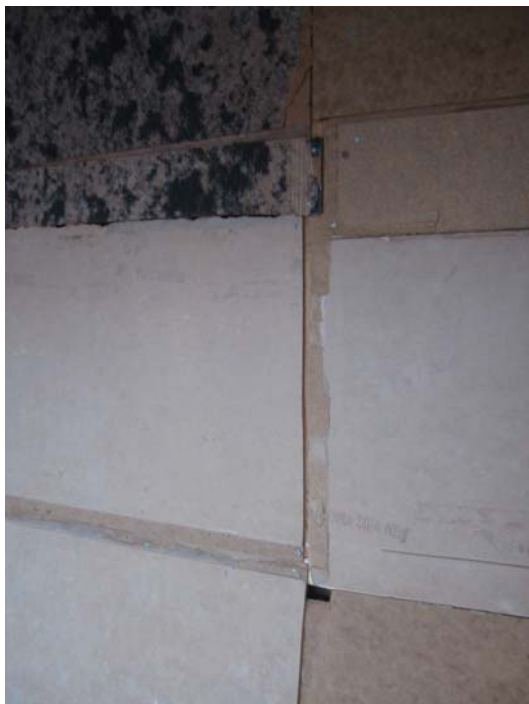
Bild 67. Vagg av ihop lappade plywoodplattor.
