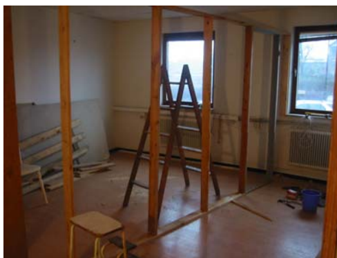
Bild 62. Byggnation av väggar.
