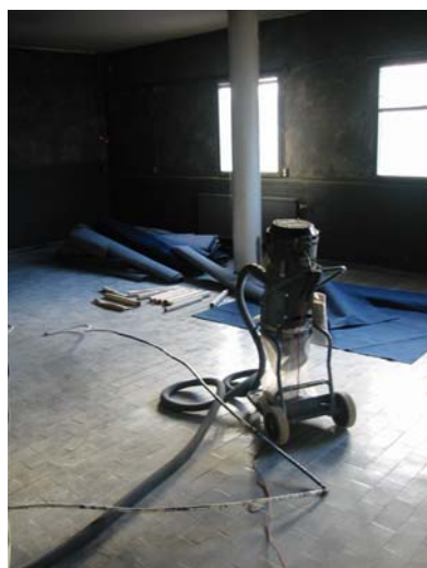
Bild 129-130. Byggnation av lobbyn
