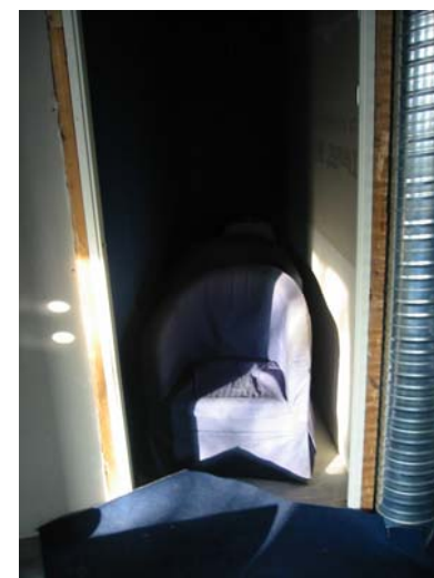
Bild 115-116. Lobbytoaletten tar form.
