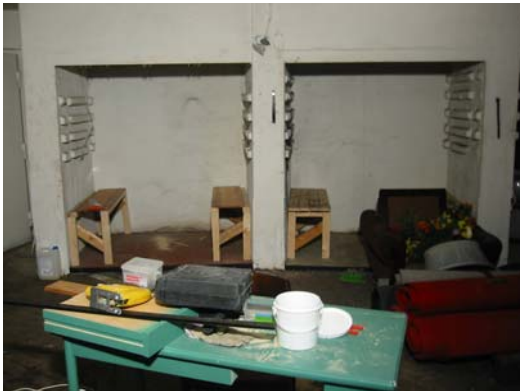
Bild 160-162. Byggnation av båsen i restaurangen
