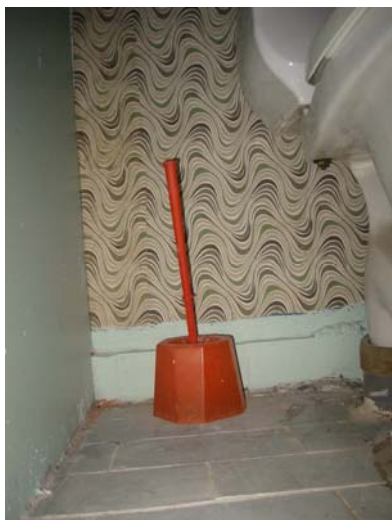
Bild 117-118. Den färdiga lobbytoaletten.
