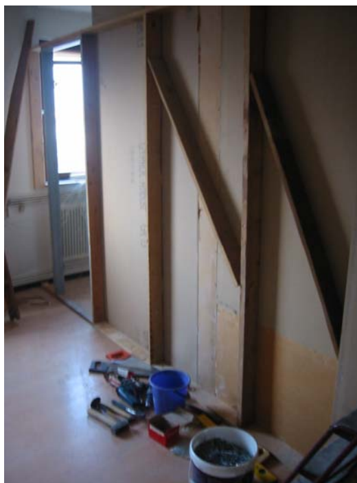
Bild 63-65. Byggnation av väggar.
